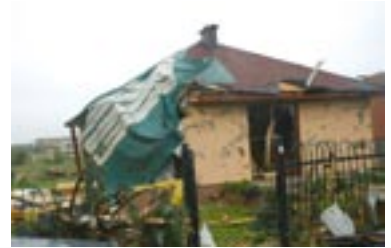
W Rusinowicach trąba nie oszczędziła nawet nowych, niezamieszkałych jeszcze budynków
