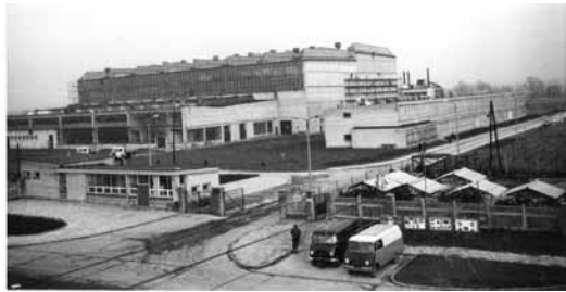
Widok ogólny zakładu – 1968 r.
