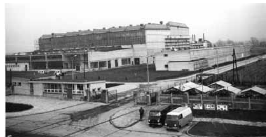
Widok ogólny zakładu – 1968 r.
