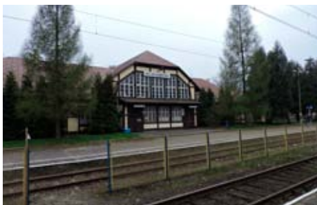
Dawna stacja Wieluń (obecnie Wieluń Dąbrowa). Tymczasowy budynek stacyjny stoi do dziś. Fot. Katarzyna Pietrzak, dnia 1 września 2015 roku.
