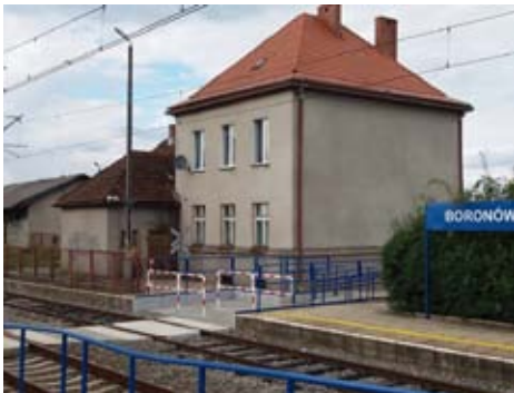
Budynek stacyjny w Boronowie – stan obecny. Fot. Łukasz Wróbel, 5 września 2016 r.
