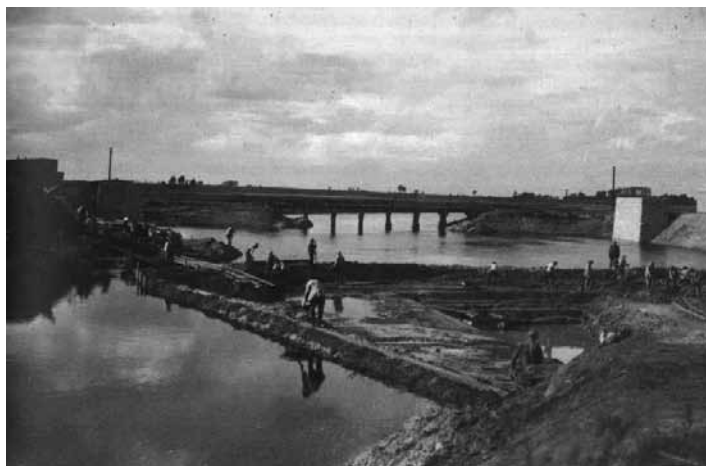
Roboty przy fundamentach pod most na Prośnie w okolicach Podzamcza-Wieruszowa, 115 km linii. Materiał udostępniony przez Andrzeja Kożę – opiekuna Sali Tradycji Magistrali Węglowej w Herbach Nowych 4 sierpnia 2016 r.
