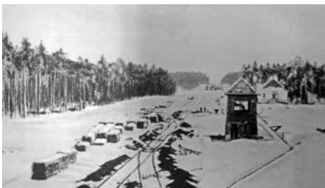
Stacja Herby Nowe, wjazd od strony stacji Kalety, zdjęcie wykonane z wiaduktu drogowego na szosie Lubliniec – Częstochowa, z października 1926 roku. Widoczna na zdjęciu nastawnia nie jest jeszcze wykończona (brak okien) wg. relacji świadków początkowo nastawniczy operował nie z nastawni, lecz z podstawionego wagonu.
