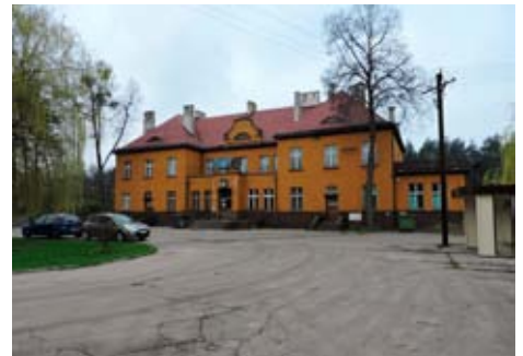
Budynek dworcowy w Herbach Nowych od drogi (ul. Wieczorka) – stan obecny. Fot. Adam Sołtykowski, 12 kwietnia 2016 r.
