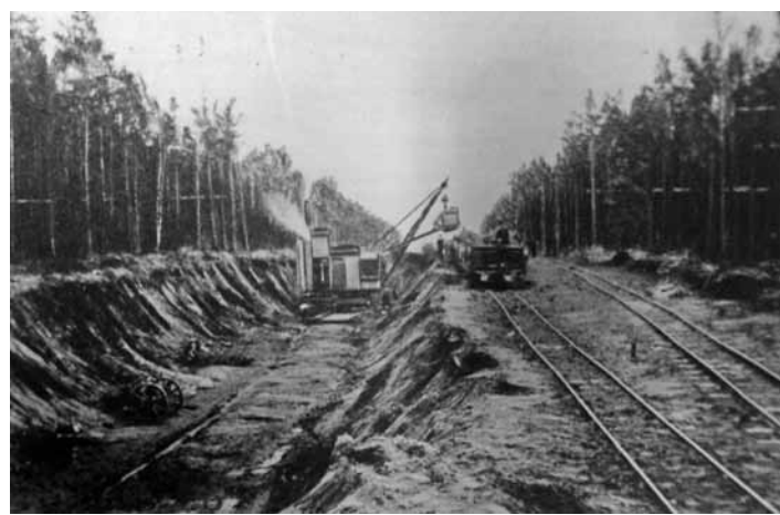
Roboty budowlane na linii kolejowej Kalety – Podzamcze, szlak Herby Nowe – Panki, 24 km linii. Materiał udostępniony przez Andrzeja Kożę – opiekuna Sali Tradycji Magistrali Węglowej w Herbach Nowych, 4 sierpnia 2016 r.
