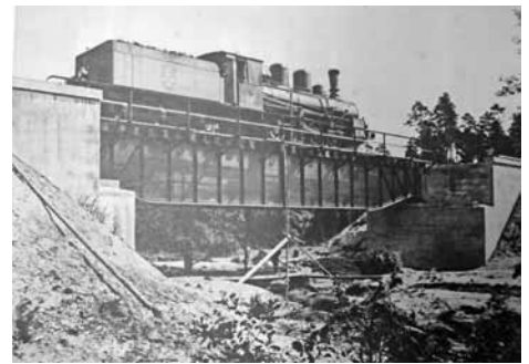
Szlak Boronów – Herby Nowe, próba obciążenia mostu nad ciekim wodnym Olszyna w okolicach przysiółka Drapacz 18 km linii. Materiał udostępniony przez Andrzeja Kożę – opiekuna Sali Tradycji Magistrali Węglowej w Herbach Nowych 4 sierpnia 2016 r.
