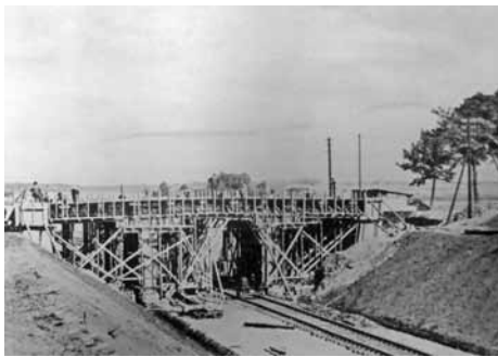
Szlak Kalety – Boronów, na torem budowa wiaduktu na szosie Lubliniec – Woźniki w miejscowości Strzebiń, 6 km linii. Materiał udostępniony przez Andrzeja Kożę – opiekuna Sali Tradycji Magistrali Węglowej w Herbach Nowych 4 sierpnia 2016 r.
