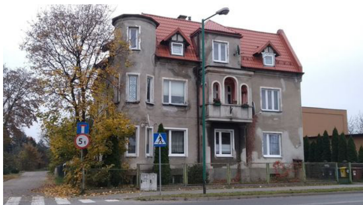
Mniej więcej w tym miejscu ok. 150 lat temu znajdowały się drewniane zabudowania Szpitala Powiatowego w Lublińcu
