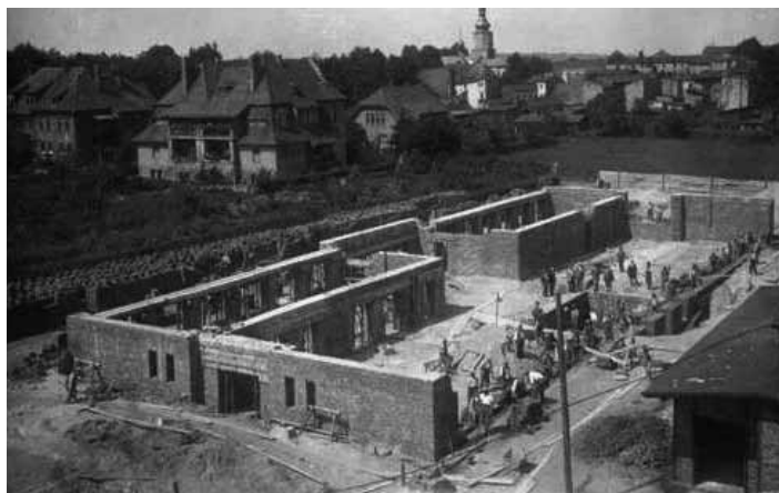
Budowa nowego gmachu szkolnego lipiec 1931 r.
