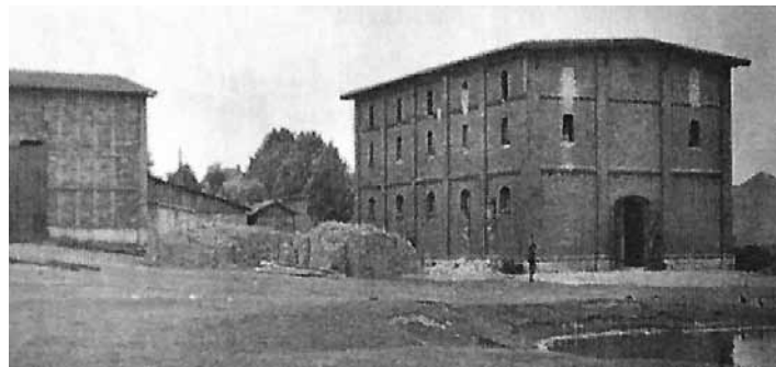
Zdjęcie przedstawiające budowę nowej szkoły w 1953 roku. Źródło: D. Nawara, Dwieście lat Ligockiej Szkoły, Woźniki 2014, s. 36.
