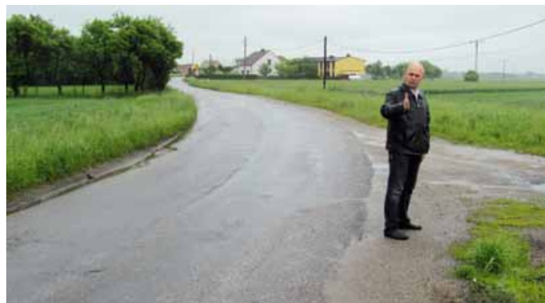
Marek Wręczycki w czasie sprawdzania stanu drogi po ostatnich opadach deszczu
