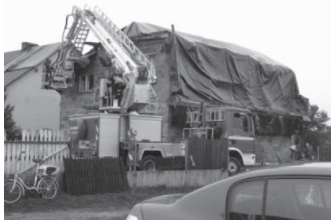
Usuwanie skutków trąby powietrznej w dniu 15.08.2008 r. (foto: Komenda Powiatowa PSP w Lublińcu)
