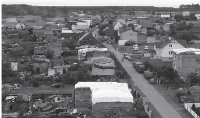
Miejscowość Kalina po przejściu trąby powietrznej w 2008 r.
