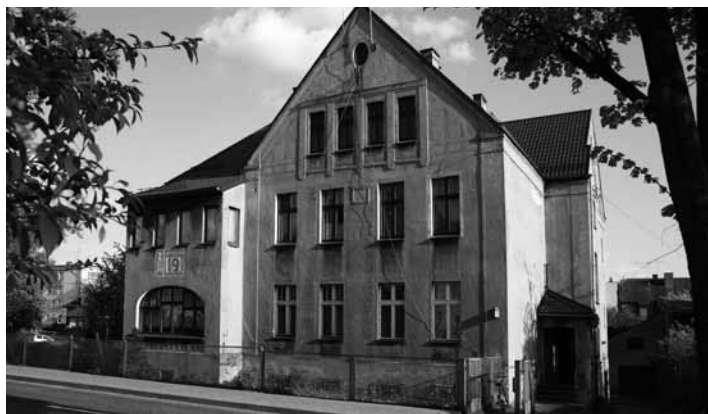
Budynek pierwszego biura ZNME w budowie – ul. Oświęcimska 19
