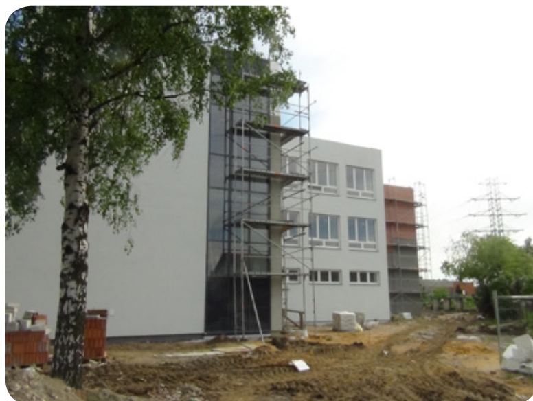
Prace przy budowie nowego skrzydła
