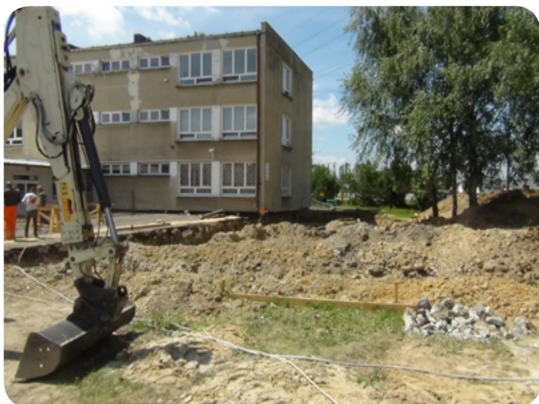
Prace przy budowie nowego skrzydła
